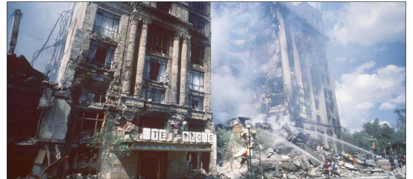
Fig. 1.24. Riesgo sísmico. Daños producidos por un terremoto.
